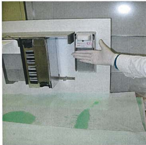
Abb.4: Fingerrückenbetätigung
